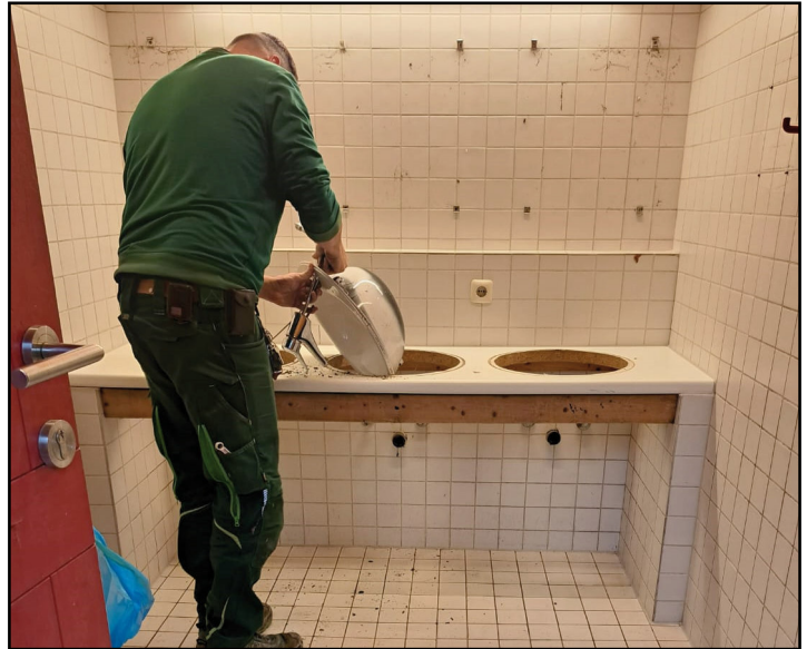
Dominik Zankl beim Abriss der alten sanitären Anlagen.
