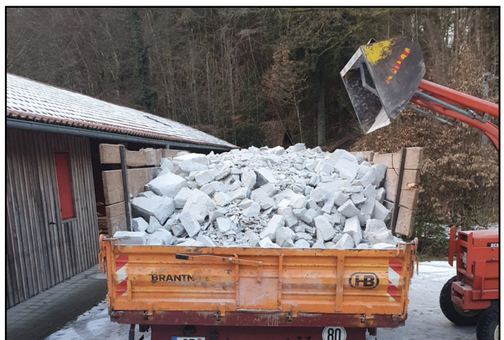
Links: Vorbereitung der Neuinstallation im Sanitärbereich.
